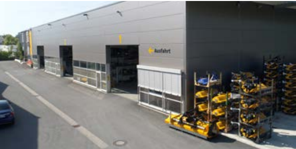
A szerelőcsarnok a soesti telephelyen – technológia tökélyre fejlesztve.
