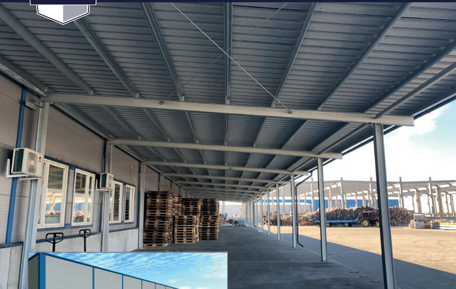
66 m x 8,5 m x 4,5 m logisztika teljes rámpafedés Megvalósulás helyszíne: Szolnok
