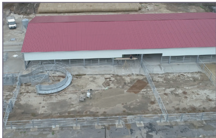
Acélváz, korszerű állattartó épület Alapterület: 18 × 42 m | Megvalósulás helye: Kőtelek | Szerkezet: acélváz tartószerkezet
