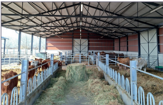
Acélváz, korszerű állattartó épület Alapterület: 18 × 42 m | Megvalósulás helye: Kőtelek | Szerkezet: acélváz tartószerkezet
