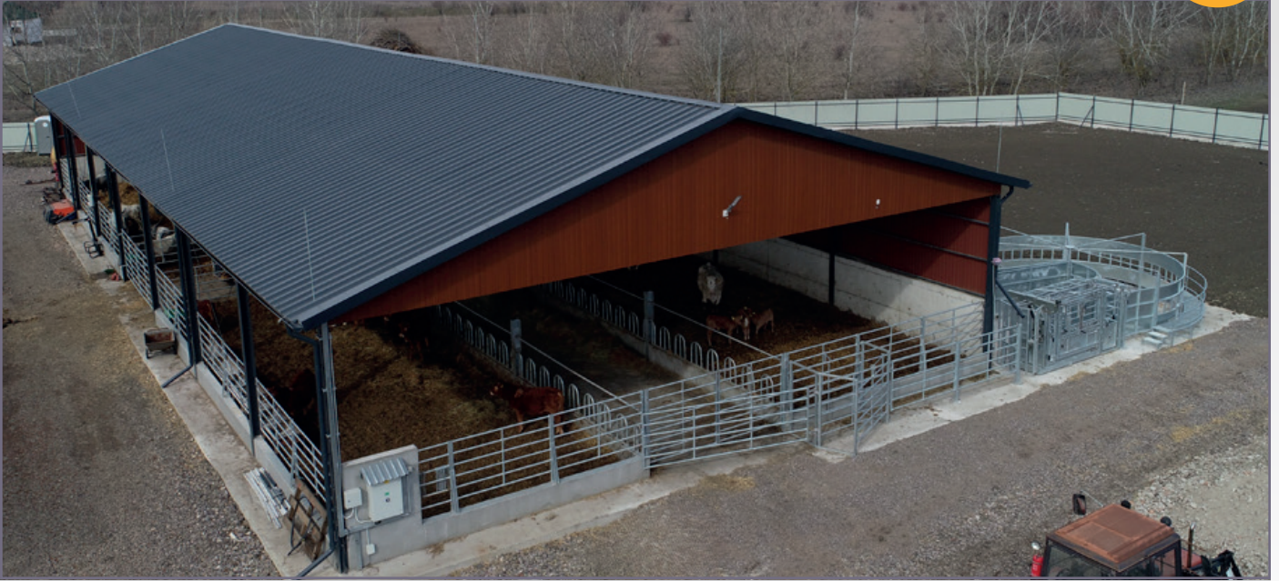
Acélvázás, korszerű állattartó épület Alapterület: 18 × 42 m | Megvalósulás helye: Kőtelek | Szerkezet: acélvázás tartószerkezet
