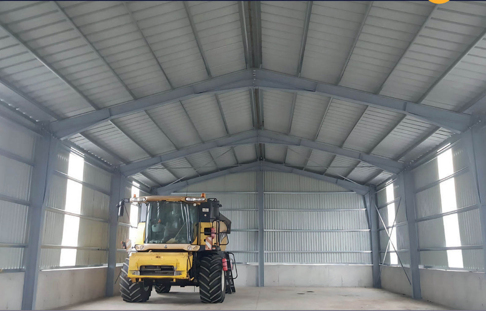
13 m x 24 m x 5 m zárt gép- és terménytároló | Megvalósulás helye: Detk
