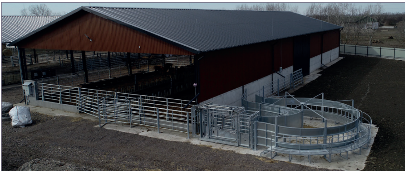
Acélváz, korszerű állattartó épület Alapterület: 18 × 42 m | Megvalósulás helye: Kőtelek | Szerkezet: acélváz tartószerkezet
