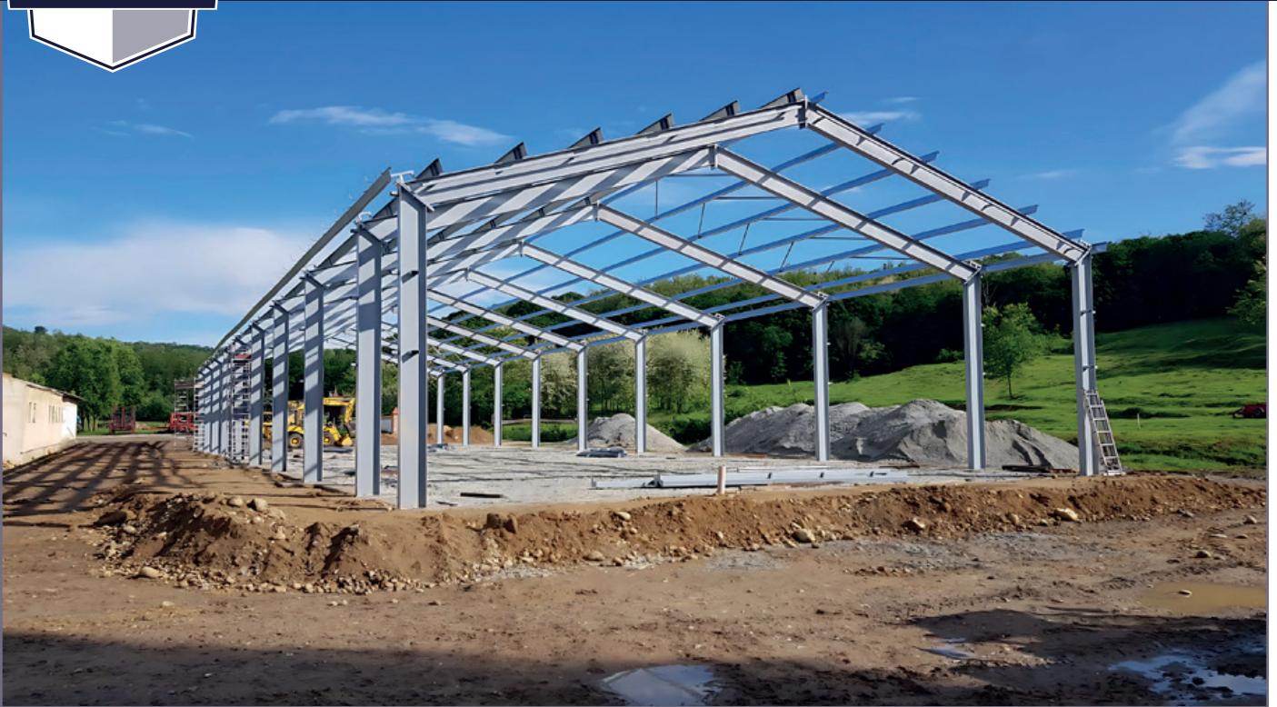
15 m x 52 m x 4,8 m terménytároló csarnok | Megvalósulás helye: Almamellék
